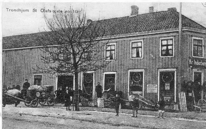
St. Olavs gate no 10
